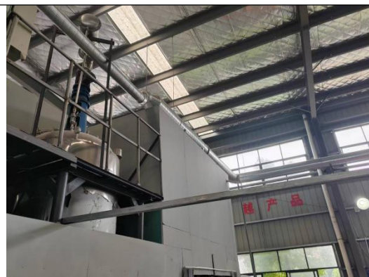
搅拌工序废气收集管道
